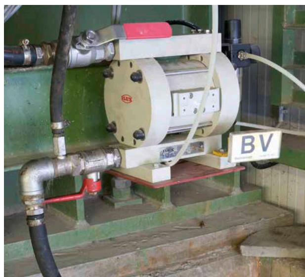
RFM: Bombeando aditivos desde un IBC a una torre de mezcla.
